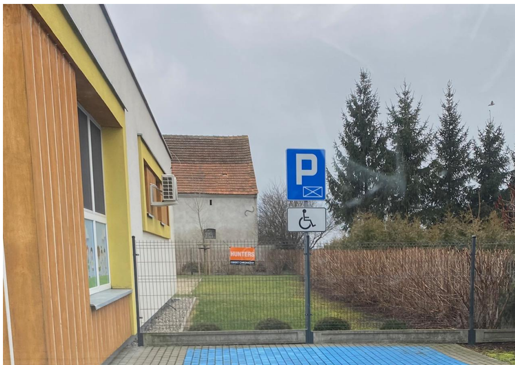
Widok na teren przylegający do elewacji zachodniej żłobka.
